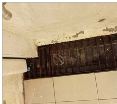
รูปที่ 2-34 ท่อรวบรวมน้ำเสียของห้องพักมูลฝอยรวม
